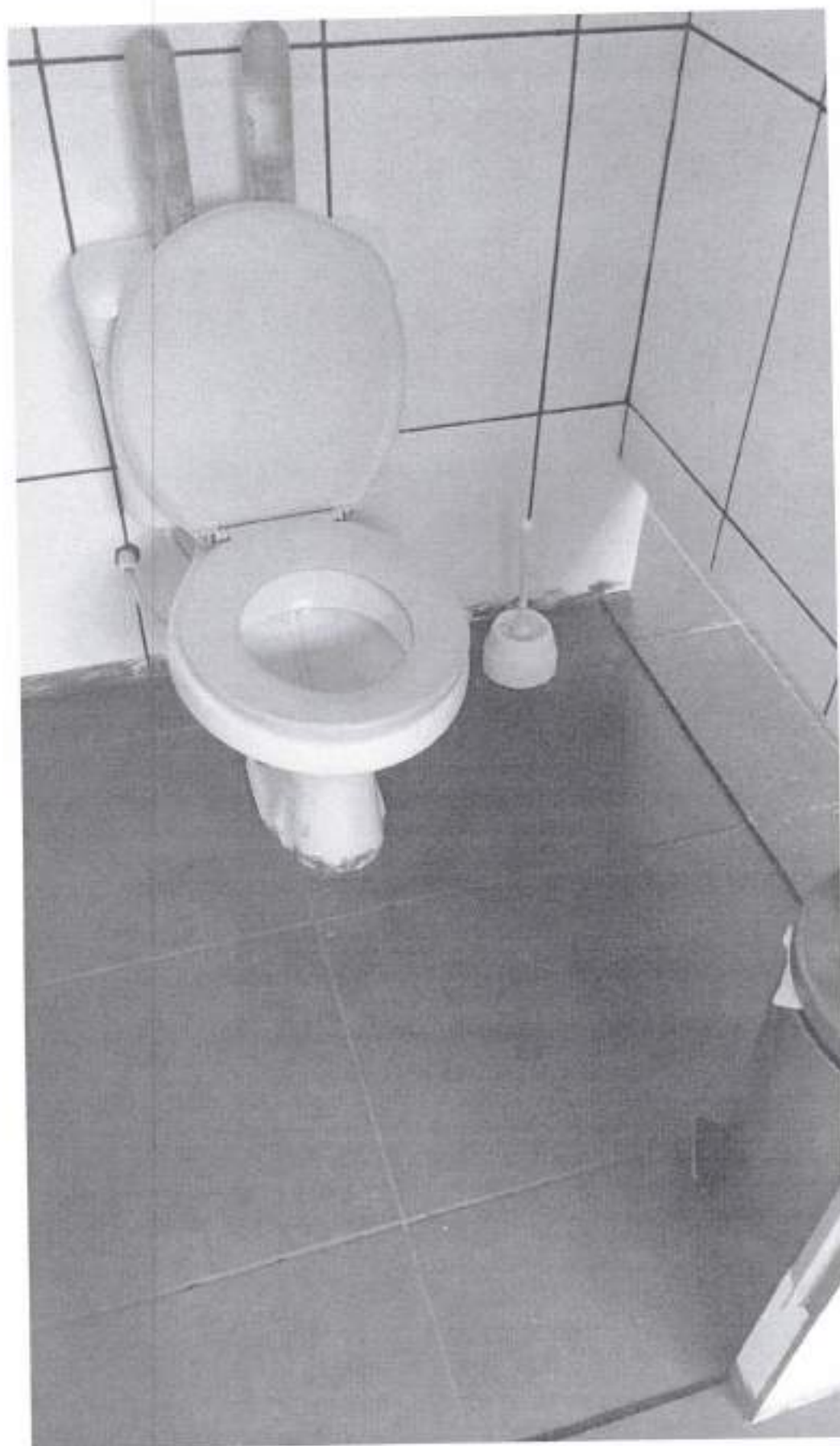
ECOBRAZIL – ECOL GESTÃO DE FACILITIES CNPJ/CPF: 32.708.178/0001-88 DEPARTAMENTO DE QUALIDADE E SUPERVISÃO OPERACIONAL – ocorrência n 002
