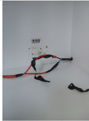
Instalação de uma tomada
