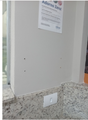
Colocação de um suporte para instalação qdo filtro de água
