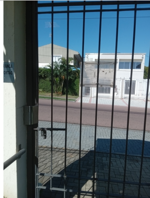
Portão de entrada concluído
