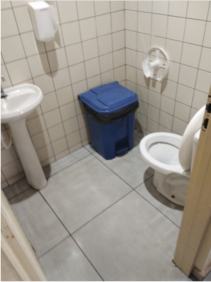
Banheiro masculino CDB
