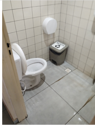
Banheiro feminino CDB
