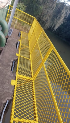
Pintura de guarda corpo na captação de água na adutora
