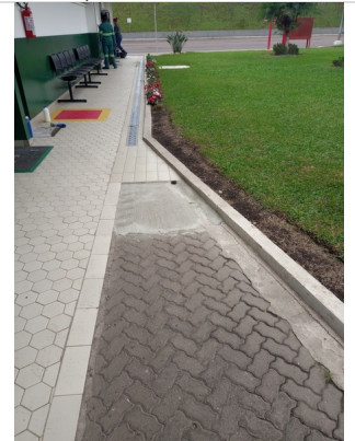
Recuperação de desnível em calçadas
