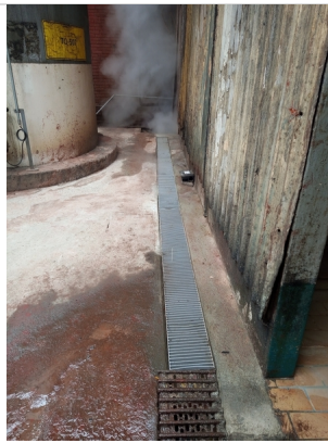
Construção de dreno na refinaria
