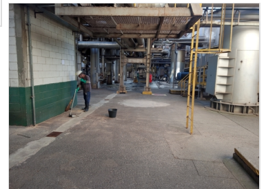
Limpeza de fabrica utilidades ok
