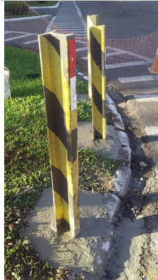
Fixação de vigas de sinalização no patio
