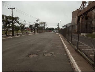
Estacionamento externo ok
