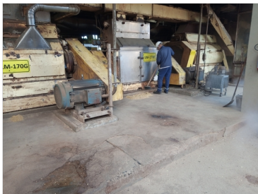
Limpeza de fabrica preparação
