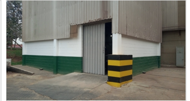
pintura interna, externa e portão do prédio da furacão pet
