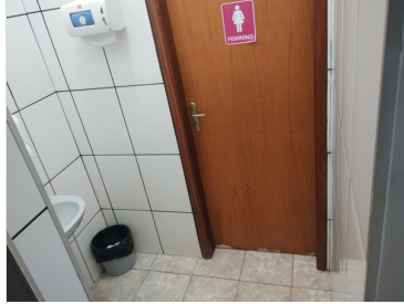
Conforme banheiro feminino.
