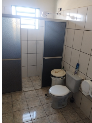
Conforme banheiro masculino.
