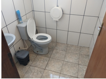
Conforme banheiro feminino.
