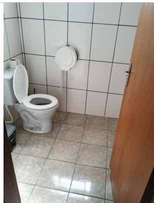
Banheiro masculino administrativo
