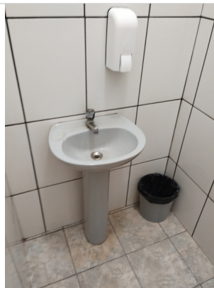
Banheiro masculino administrativo
