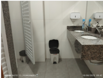
conforme, banheiro feminino
