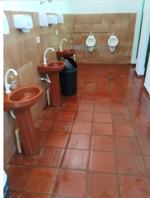
Banheiro masculino operacional
