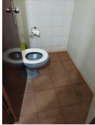
Banheiro masculino administrativo
