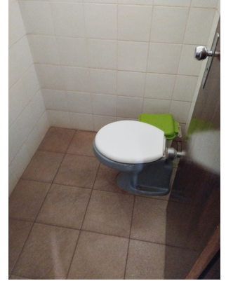
Banheiro feminino administrativo
