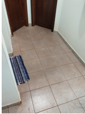
Entrada do banheiro administrativo
