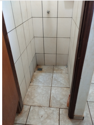
Banheiro masculino operacional, colaboradora está iniciando hoje as atividades
