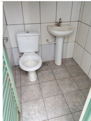
Banheiro sala de classificação
