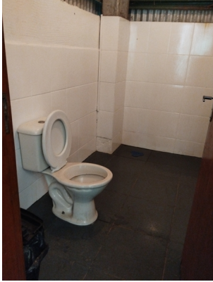
Banheiro masculino operacional
