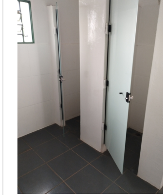
Banheiro masculino operacional
