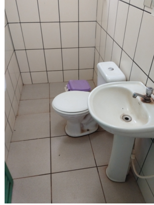
Banheiro da sala de classificação
