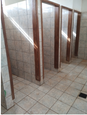
Banheiro masculino operacional
