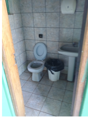
Banheiro operacional feminino
