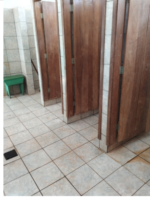
Banheiro masculino operacional
