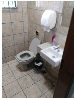
Banheiro feminino administrativo
