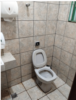
Banheiro masculino administrativo
