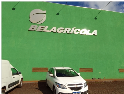
Limpeza de Fachada (tirar foto do Letreiro e Fachada)
