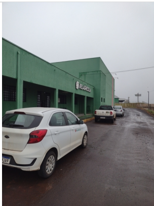
Limpeza de Fachada (tirar foto do Letreiro e Fachada)
